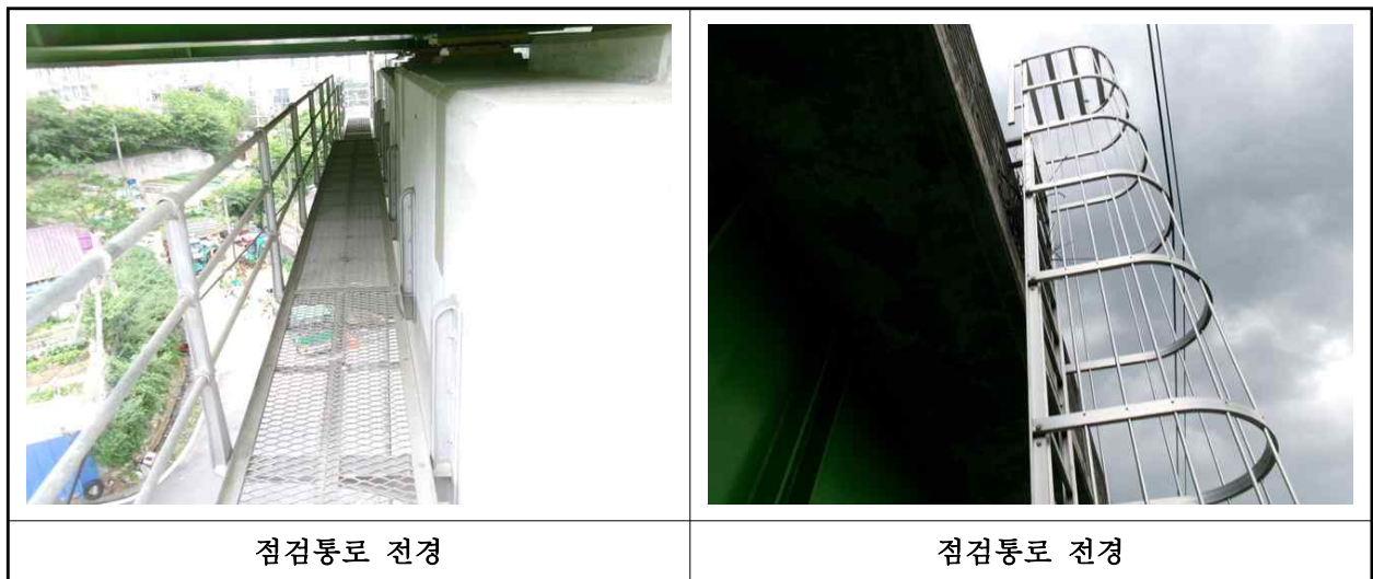
【사진 3.3.25】 교량 점검시설 전경
