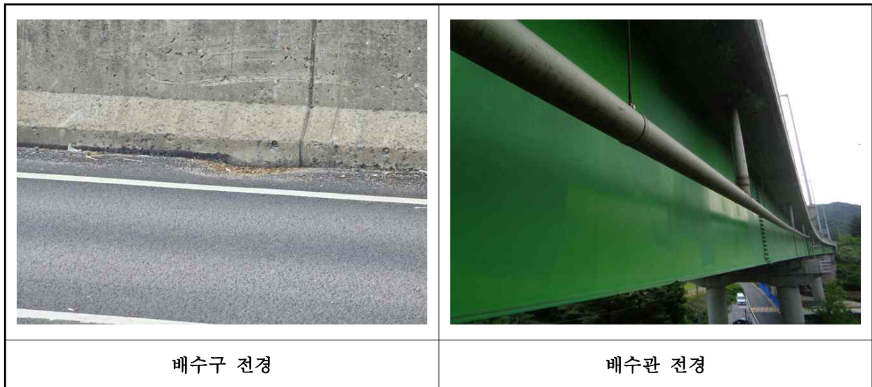
【사진 3.3.21】 배수시설 전경
