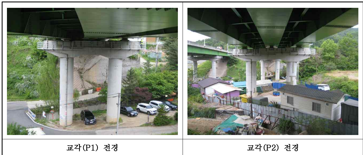
【사진 3.3.10】 교각 전경
