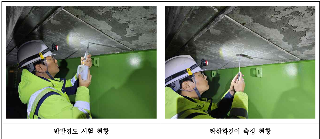
【사진 3.4.1】 콘크리트 내구성조사 현황
