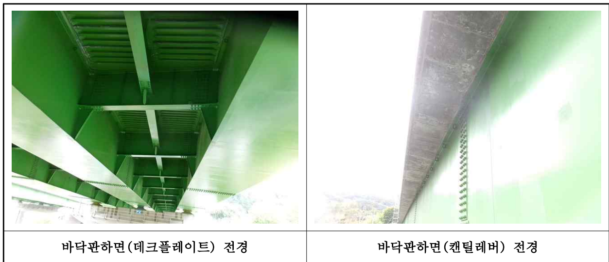
【사진 3.3.2】 바닥판하면 전경
